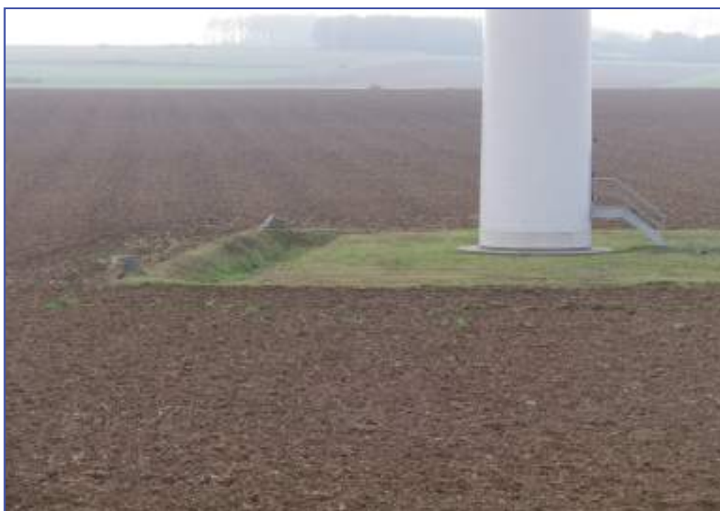
Photo 2 : Exemple de noue en limite de plate-forme
